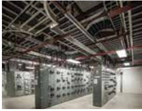
Tioga Gas Plant
