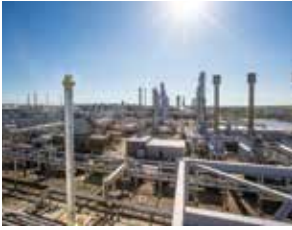
Tioga Gas Plant
