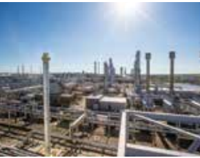
Tioga Gas Plant
