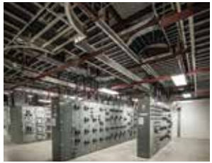
Tioga Gas Plant
