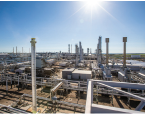
Tioga Gas Plant
